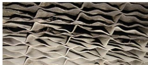
ب: نمایی از پروفیل مدل موج دار دوبل (DU)
