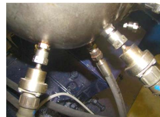
شکل ۸ نحوه نصب حسگرها روی سطح
