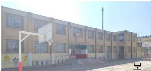
شکل ۳ الف) نمای مدل‌سازی شده ساختمان در نرم‌افزار دیزاین بیلدر، ب) وضع موجود موجود ساختمان مدرسه احسان
