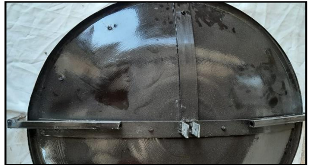
شکل ۳ استفاده از تسمه آهنی برای استحکام و اتصال
