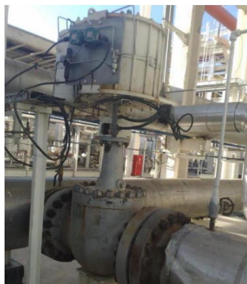
شکل ۲ شیر پرخشی (توپی) کلاس ۹۰۰ با محرک نیوماتیکی
